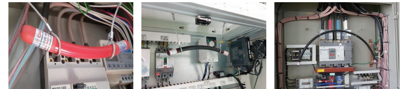
초경량 튜브 소화기 적용 사례 Case of ultra light tube fire extinguisher application
